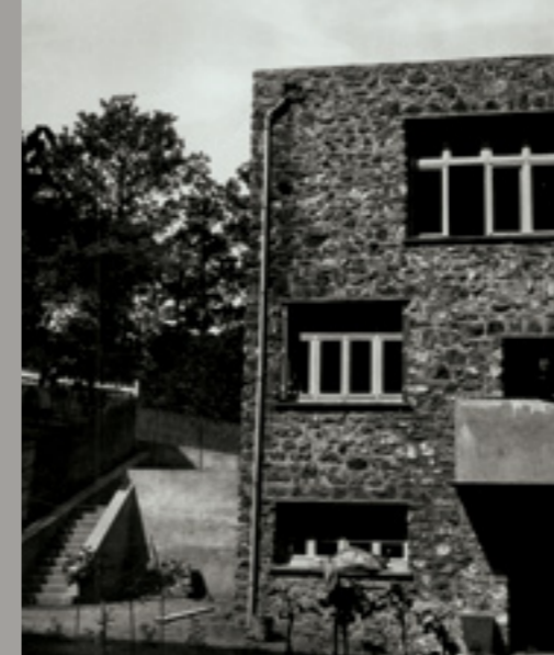
Zaprojektowany przez Sophie Taeuber-Arp dom-studio w Meudon (później część Clamart), ok. 1927-1928 Studio-home in Meudon (later a part of Clamart) designed by Sophie Taeuber-Arp, c. 1927-1928
